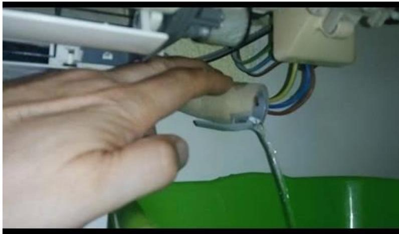
EL agua que genera el aire acondicionado son totalmente normales y son el resultado del proceso de **evaporación** que tiene lugar en el interior de la máquina.
